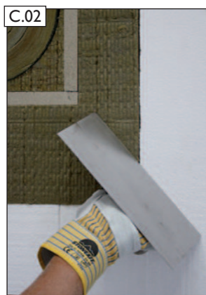
Skontrolujte tepelnú izoláciu na mieste styku.
