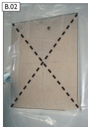
B.02 Parotesnú vrstvu prerežte priečne na požadovanú veľkosť otvoru (pozri obrázky A.1 a A.2).
