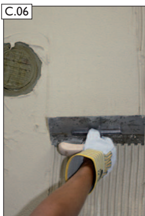
Pripravte podklad pre osadenie sieťky
