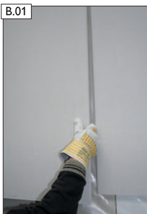
B.01 Odstráňte sadrokartón. POZOR! Parozábrana nesmie byť poškodená!
