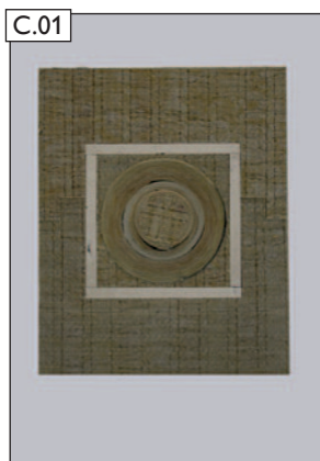
Pohľad pred začiatkom montáže
