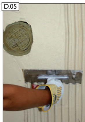
Pripravte podklad pre osadenie sieťky.
