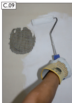
Naneste penetráciu. Dodržte pri tom pokyny a deklaráciu výrobcu omietkového systému.
