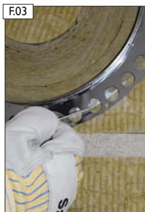
Rozetu prichyťte hrotmi(klincami) z nehrzdavejúcej ocele.
