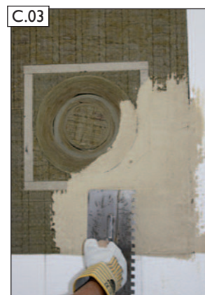
Prvú vrstvu nanášajte iba na vonkajšiu stranu IGNIS PROTECT. POZOR! Neprekryte vnútorné ochranné izolačné prvky!
