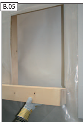
B.05 Nainštalujte nosné drevo pre IGNIS PROTECT do dreveného rámu.
