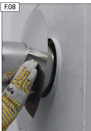
Osadte dymovod, zabezpečte tesné spoje a osadte prekryvnú rozetu.
