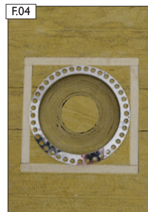
Pred započatím zhotovenia povrchovej úpravy (omietaním) overte vycentrovanie, presnosť osadenia rozety!
