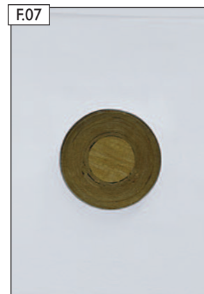
Pohľad na zrealizovanú konečnú povrchovú úpravu - omietku na prechode IGNIS Protect.
