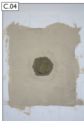
Pohľad na zrealizovanú prvú vrstvu.
