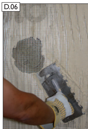
Zatrite do podkladu sieťku.
